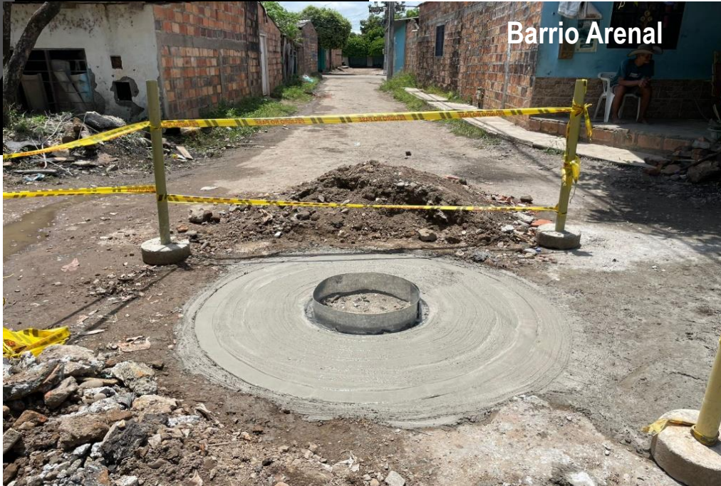
REALCE DE POZO DE INSPECCION Y CONSTRUCCION PLACA CORONA
