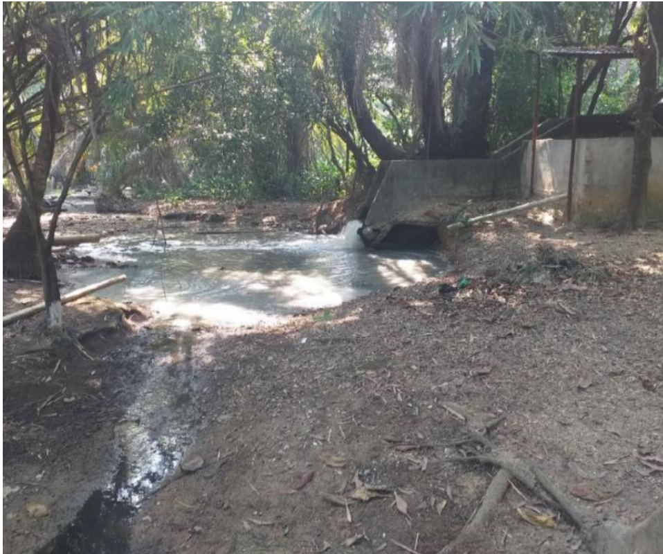
Inicio Colector Coviba salida a la vía principal del Barrio Campo Hermoso.
