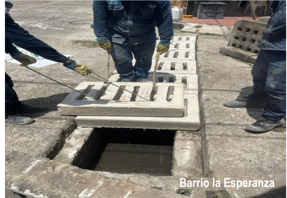
SUMINISTRO E INSTALACION DE REJILLA SUMIDERO
